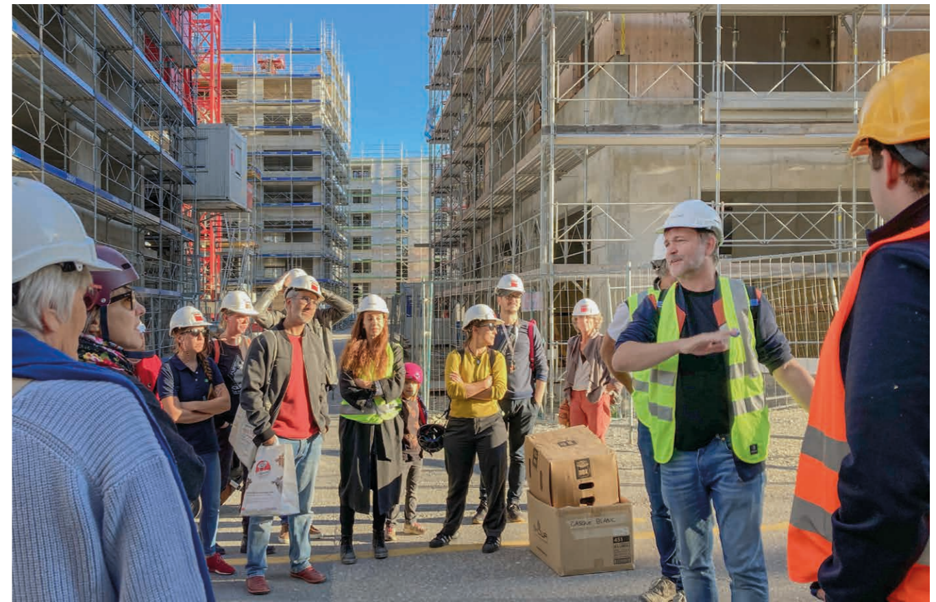
Visite de chantier des coopérateur-trices © Cudha
