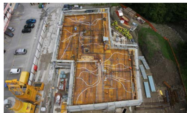
Chantier ch. de Bonne-Espérance Pose d'un double flux dans les dalles
