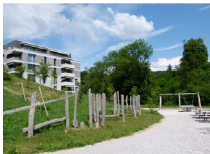
Chemin de Maillefer 233 logements Minergie Eco
