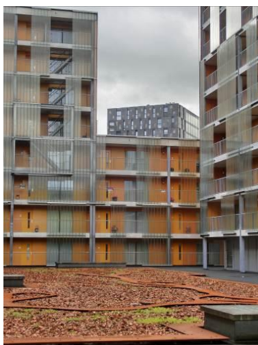
▲ Revêtement perméable de tessons de terre cuite
