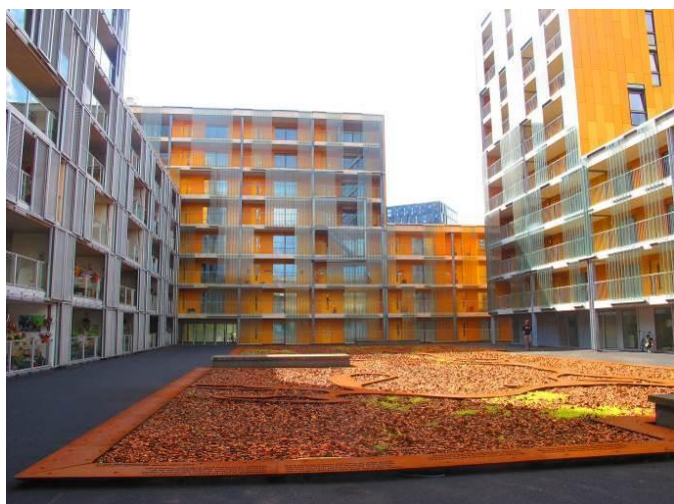
▲ Un système de coursives extérieures
